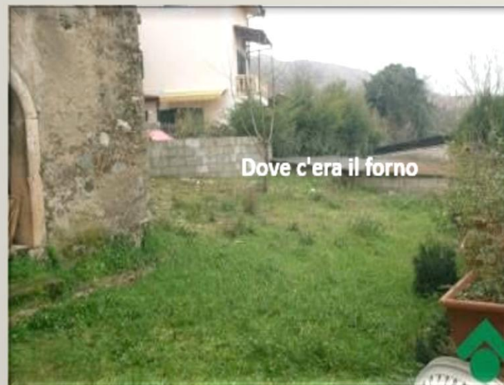
La foto indica dove era posizionato il forno, poi demolito
